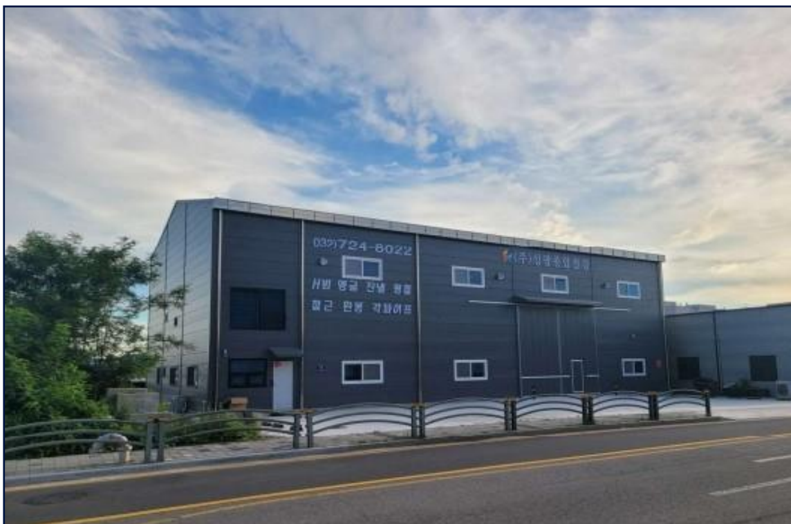
경기도 김포시 양촌읍 학운리 3200번지 제2종 근생 신축공사
