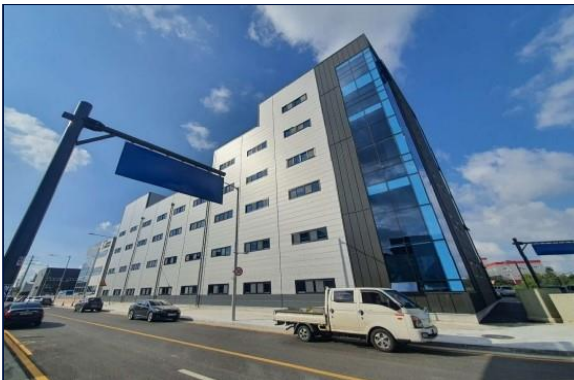
김포시 대포 일반산업단지 신OO공장 신축공사
