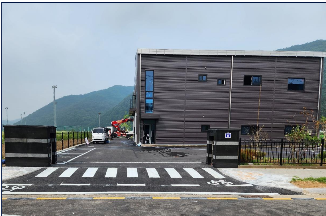
법원2 일반산업단지 (주)그000 공장 신축공사
