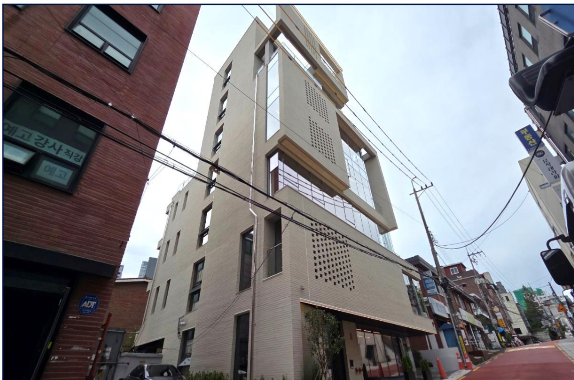
강남구 도곡동 950-0번지 근생 신축공사
