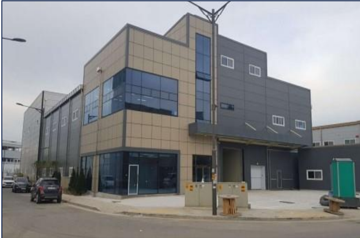
서구 금곡동 (주)레오 공장 신축공사
