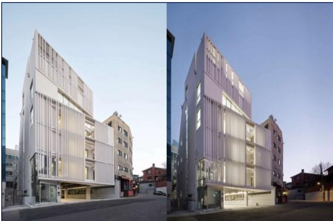
서초구 서초동 1600-0번지 근생 신축공사
