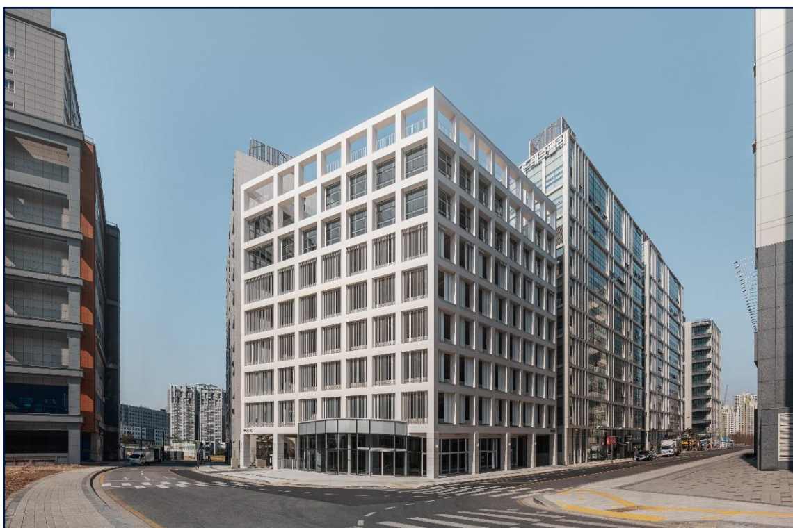
경기도 하남시 하남미사 주OO 주차장 및 복합시설 신축공사
