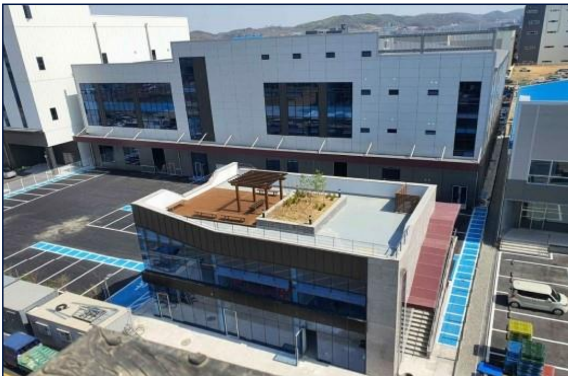
김포시 양촌읍 학운리 학운3산업단지 다OO㈜ 공장 신축공사
