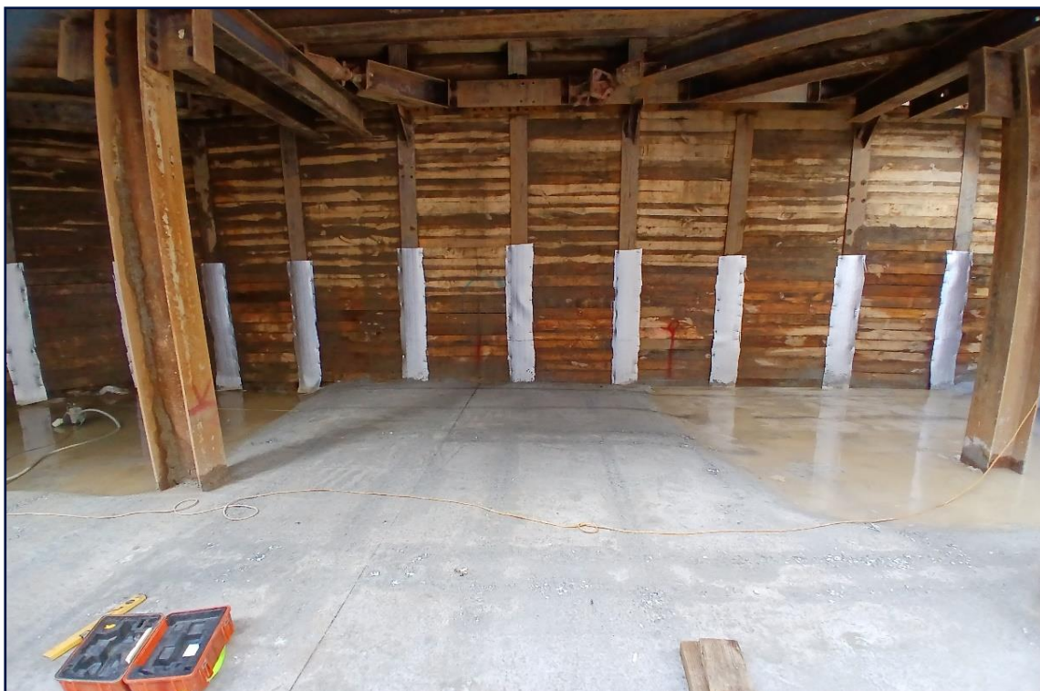
서초구 반포동 730-0번지 근생 신축공사 [시공중]
