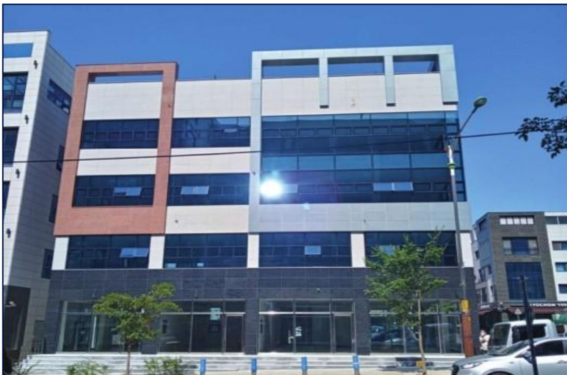
서구 가정동 610-00 근린생활시설 신축공사
