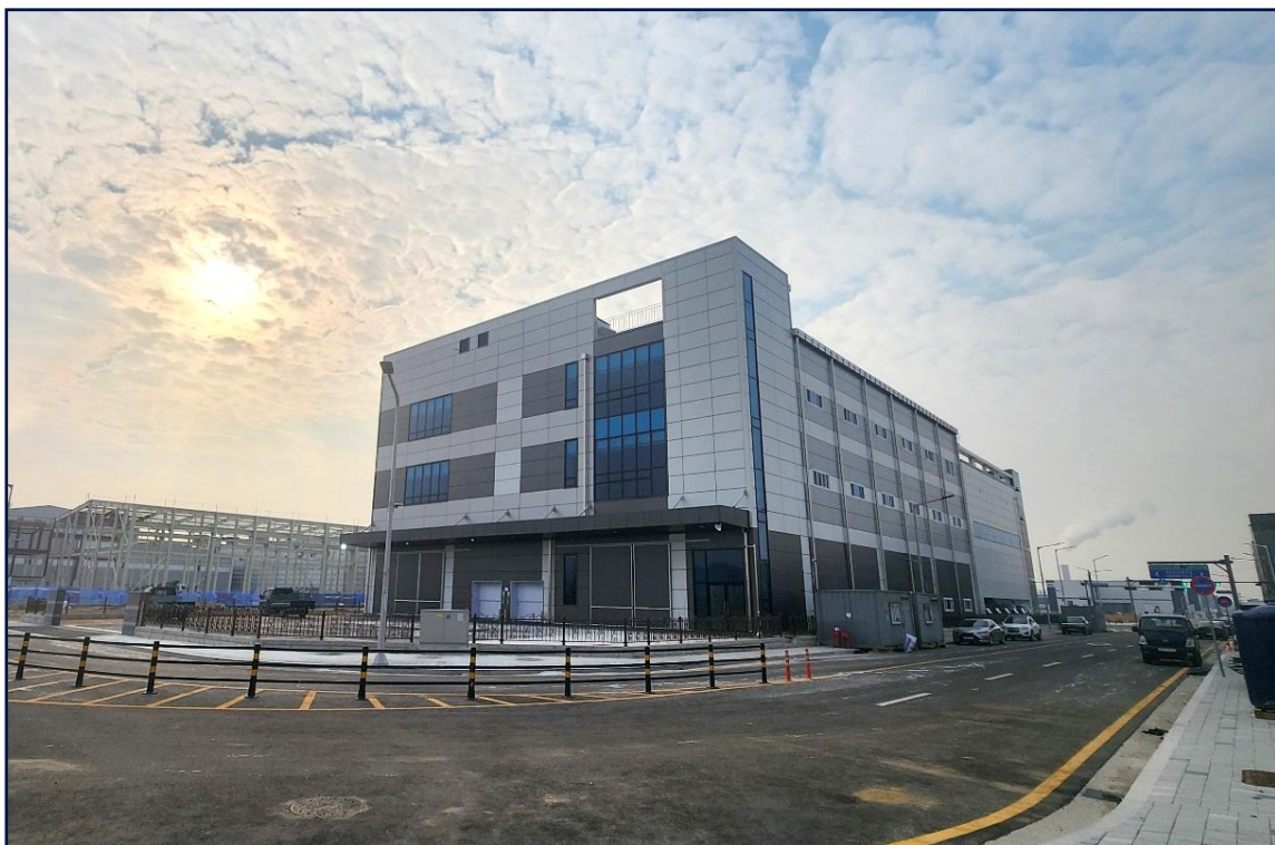
학운5산업단지 00블럭 O로트 공장 신축공사
