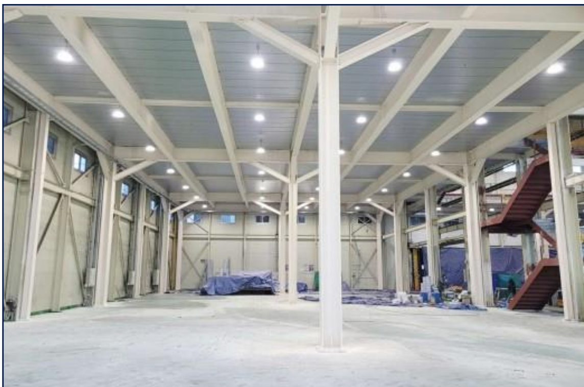
인천광역시 남동구 논현동 430-00번지 공장 증축공사
