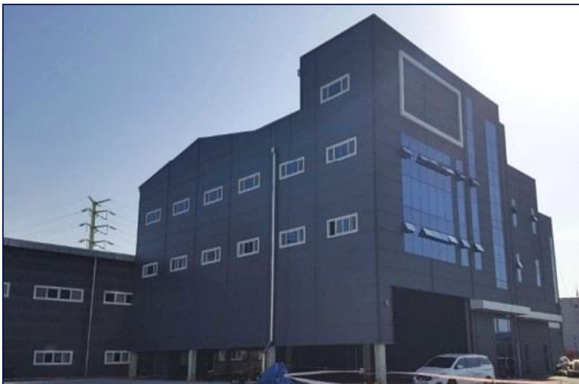
김포시 대포산업단지 (주)엘000 공장 신축공사
