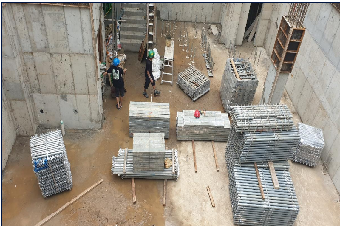
강남구 역삼동 740-0번지 근생 신축공사 [시공중]
